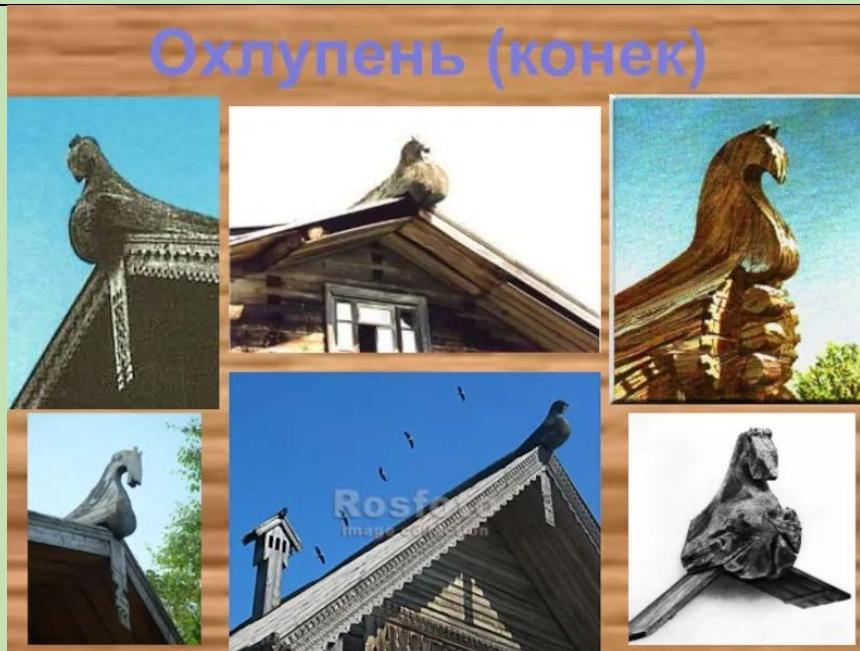
верхнее обрамление крыши крестьянской избы. Это толстое тяжелое бревно с выдолбленным снизу желобом. Охлупень прикрывал стык скатов и придавливал своей тяжестью концы кровельных досок.
