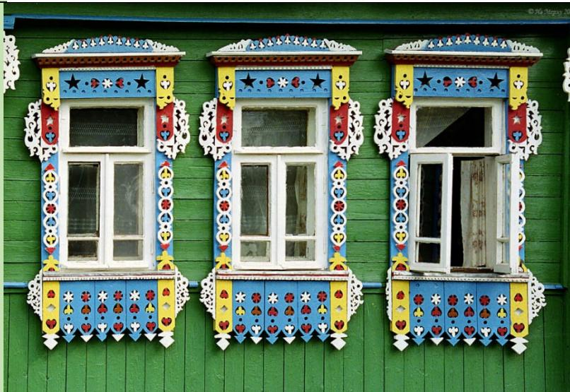
Наличником называется архитектурная деталь, которая обрамляет оконный, реже — дверной проем. У наличника есть не только декоративная, но и конструктивная функция: он закрывает щель между стеной и оконной коробкой. На Руси деревянные наличники богато украшали резьбой. Тонкая работа свидетельствовала о богатстве хозяина дома. В каждой области у мастеров были свои
