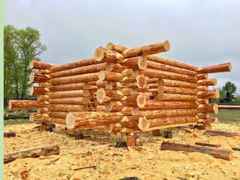
деревянное сооружение, стены которого собраны из обработанных (рубленых) брёвен,
